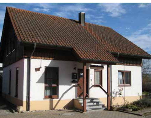
Das Bruder-Konrad-Haus in der Badstraße 31 bietet Übernachtungsplätze und Aufnahme nach §§ 67-69 SGB XII. Es ist ein Aufenthalt bis zu drei Monaten möglich.
